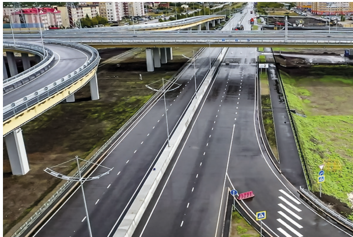
Строительство путепровода и транспортной развязки в разных уровнях на пересечении железной дороги в районе ПМК-9, г. Новый Уренгой
