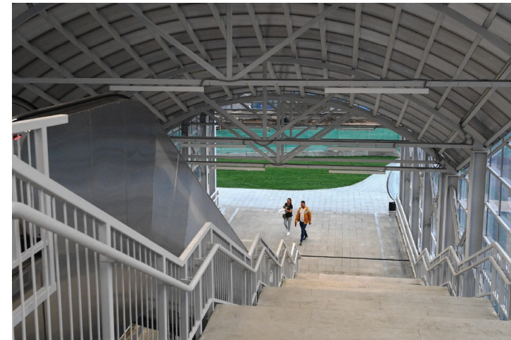
Надземный пешеходный переход через пути МЖД-2, г. Щербинка
