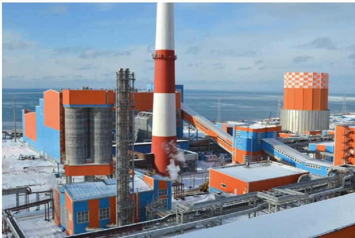
Сахалинская ГРЭС-2, 1-я очередь строительства
