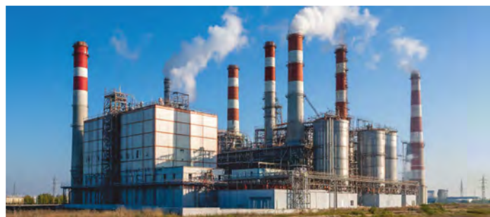
Электростанция комбинированного цикла, г. Сумгаит (Азербайджан)
